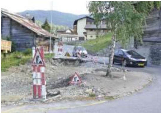
3. Kurve vor dem Abriss
